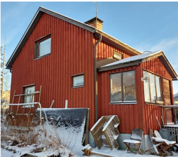
Kuva 3: Asuinrakennus kuvattuna vuonna 2024.
