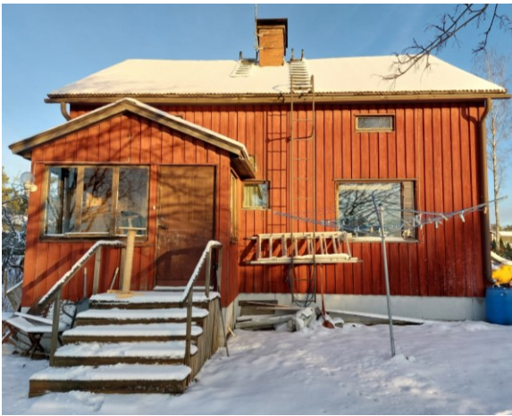
Kuva 2: Asuinrakennus kuvattuna vuonna 2024.
