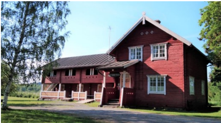
Kuva 4 Vuonna 1909 valmistuneessa aittarakennuksessa yhdistyy ateljeerakennus ja rinta-aitta (Knuutilan kartanon asemakaavatasoinen rakennetun ympäristön, piha ja maiseman inventointi, Sweco Infra & Rail Oy, 14.11.2023)
