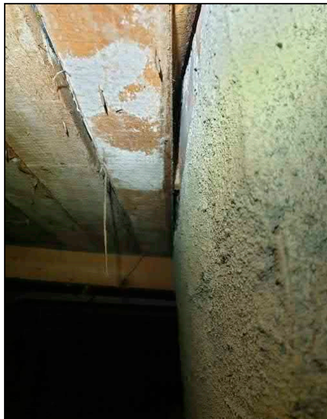
Ruuteen ja muurin välinen oleskelurako.
