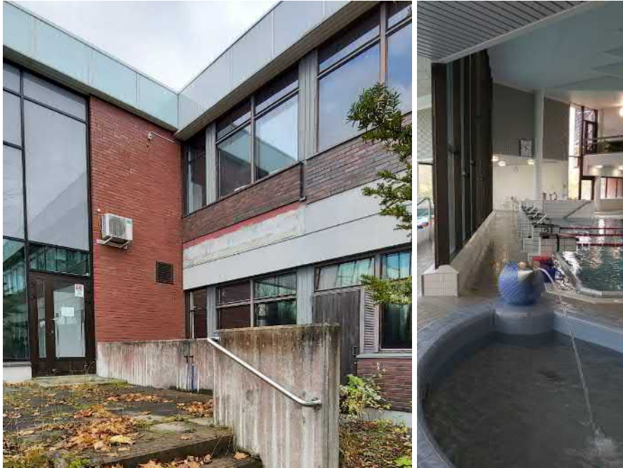
Vasemmalla valokuva saumakohdasta, jossa rakennuksen alkuperäinen länsisiipi liittyy laajennusosaan. Puretun parvekkeen sijainti erottuu alkuperäisestä julkisivusta. Oikealla alkuperäisen ulkoseinän sijainti pienten lasten kahlualtaan takana.
