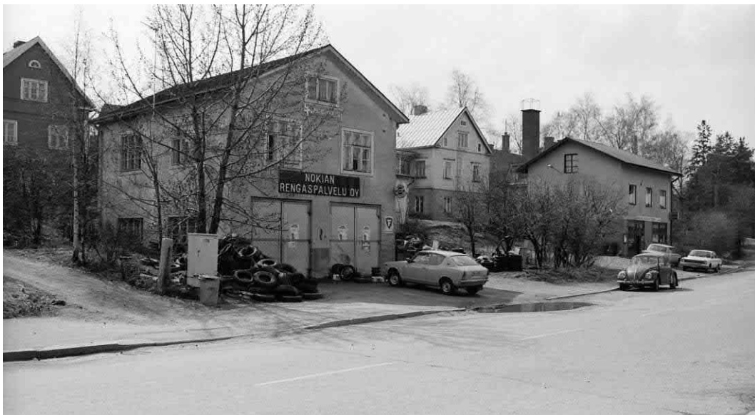
Kuva: 9 Välikadun 1950-luvun rakennuksia kuvattuna vuonna 1982. Valokuva Tuomas Koponen https://oloneuvos.kuvat.fi/ .
