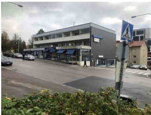
Kuva: 60 Näkymä Kauppakadun ja Korkeemäenkadun risteyksestä. Kuvassa inventoitu asuin- ja liikerakennus, kohde nro 1.
