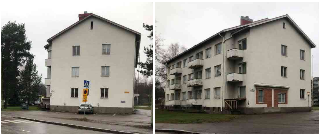
Kuva: 75 Päätyjulkisivuja Poutuntien suuntaan.
