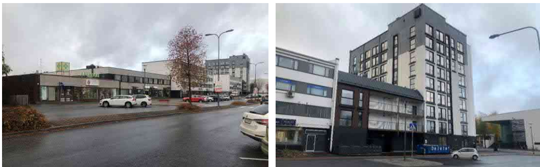
Kuva: 83 Vasemmalla Välikadun eteläreunaan rakennuksia ja Välikadun leveää katutilaa. Oikealla uudisrakennus Härkitien ja Välikadun risteyksestä, taustalla kirjasto- ja kulttuuritalo Virta.
