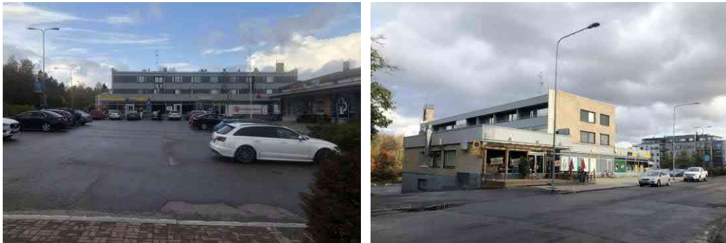
Kuva: 69 Entinen Sokos-halli (inventointikohde nro 4) rajaa Toivontoria länsipuolelta.
