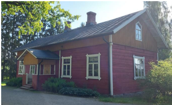
Kuva 29 Väentupa on perinteinen punamultainen hirsirakennus, jonka pystylauditukset on maalattu keltaisiksi.
