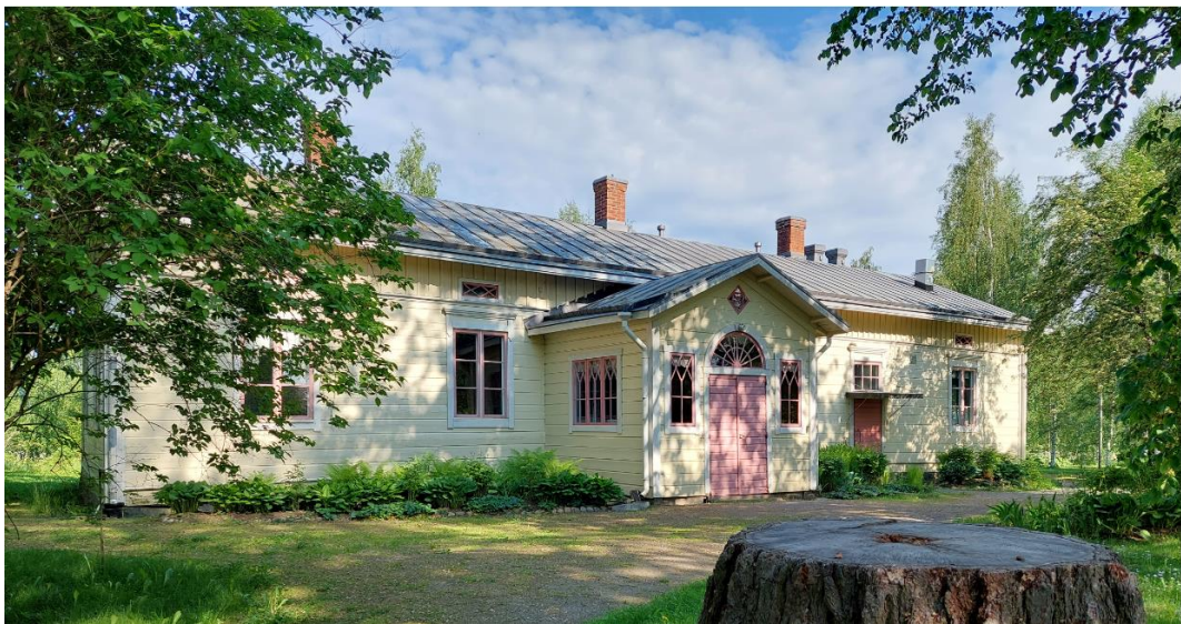
Kuva 26 Päärakennuksen julkisivua. Vuonna 1862 valmistunut osa etualalla ja 1800-luvun lopulla rakennettu jatke toisessa päädyssä.
