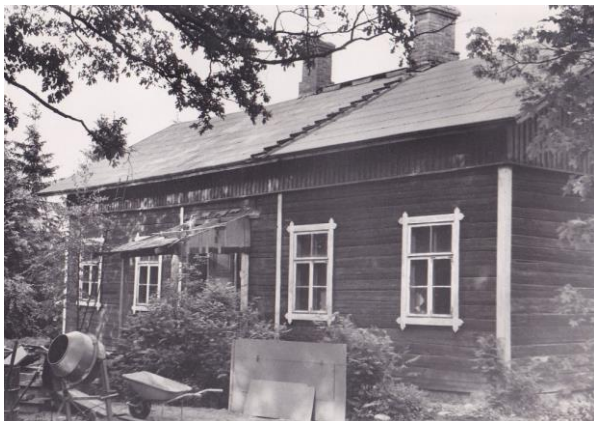
Kuva 30 Väentuvasta uusittiin 1980-luvulla kuisti, minkä lisäksi vajonneita kulmia suoristettiin. Kuva: Ossi Somma, 1984.
