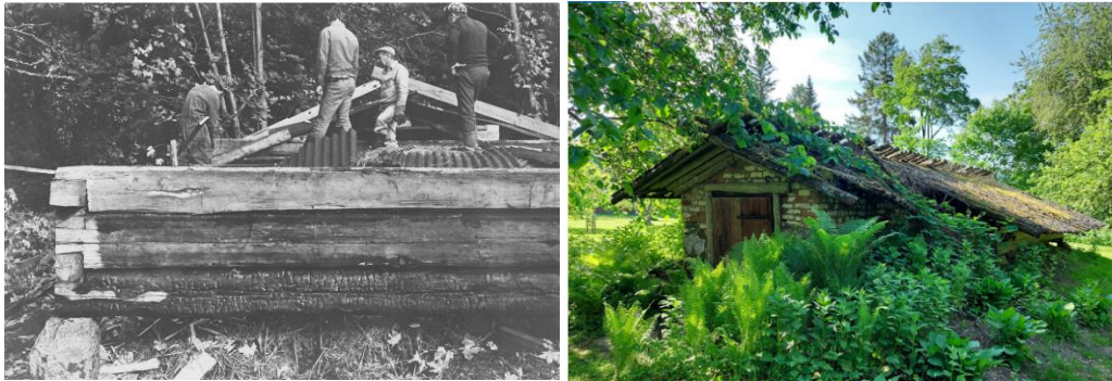
Kuva 35 Holvikellarin huonokuntoinen katto uusittiin nykyasuunsa vuonna 1979. Vasemmanpuoleinen kuva Ossi Somma, 1979.
