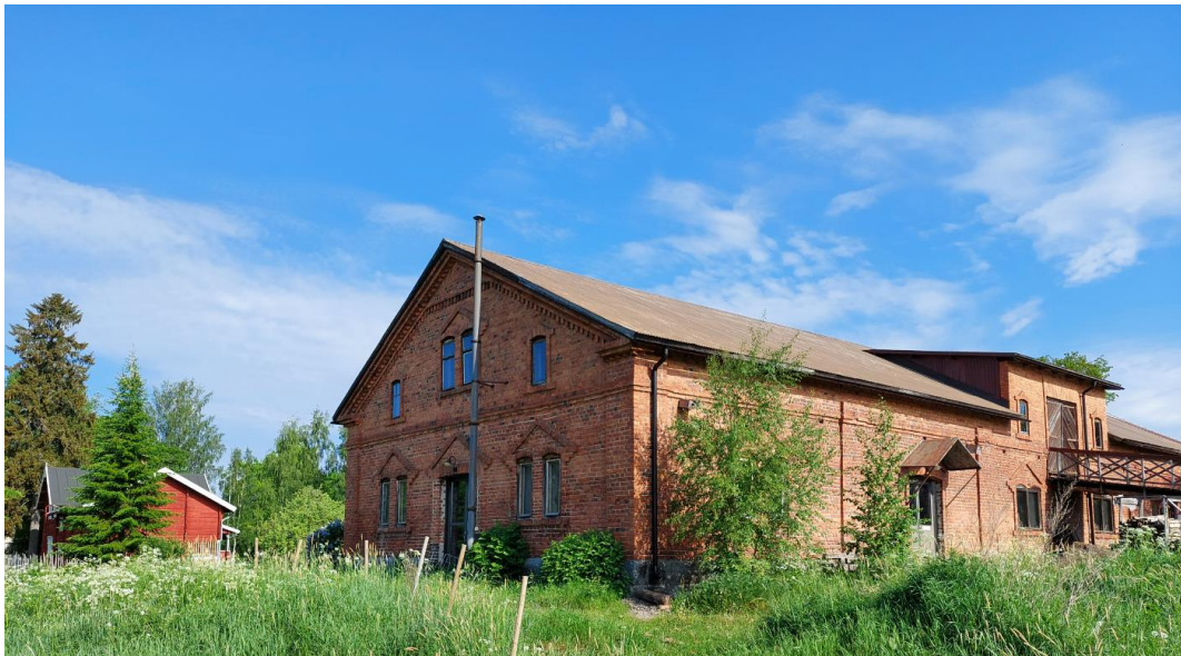
Kuva 34 Knuutilan navetan eteläpäätä, itäistä sivua ja ylisille johtavaa siltaa. Taustalla aittahotellin pääty.
