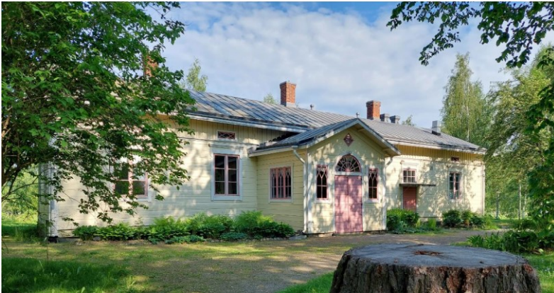
Kuva 5: Päärakennus (Kuva: Knuutilan kartanon asemakaavatasoinen rakennetun ympäristön, pihan ja maiseman inventointi)
