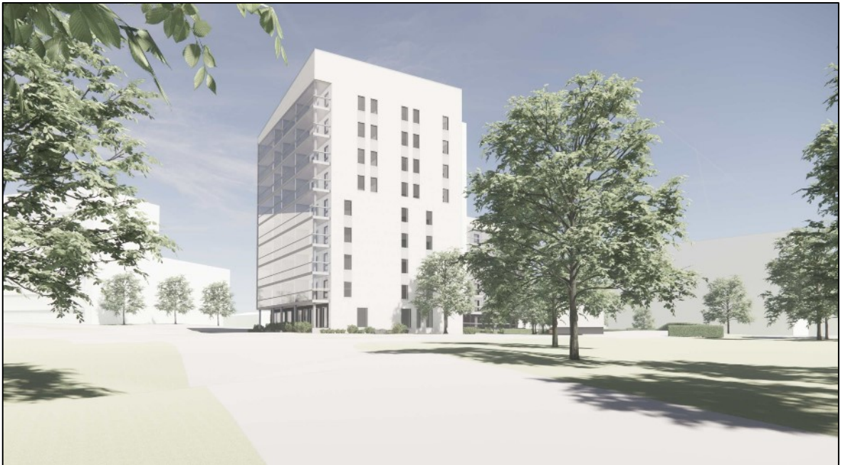
Kuva 12. Näkymä etelästä Souranderintieltä. Kuvassa Sotkanvirran kiinteistön uusi 9-kerroksinen rakennus. Vasemmalla katunäkymän päätteessä matkakeskuksen asemakaava-alueen mukaista rakentamista.
