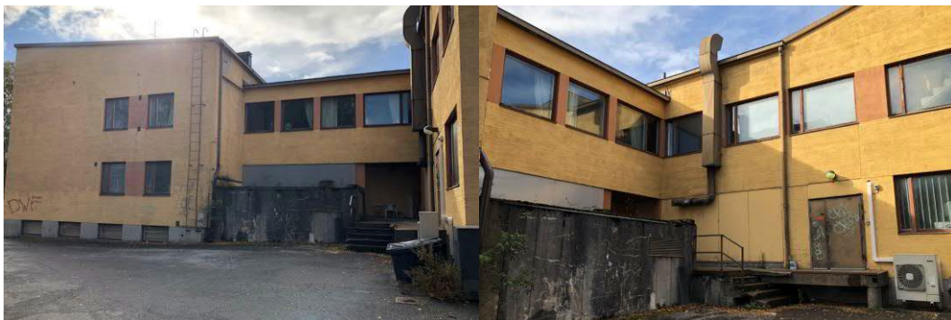
Kuva: 41 Julkisivua koilliseen.
