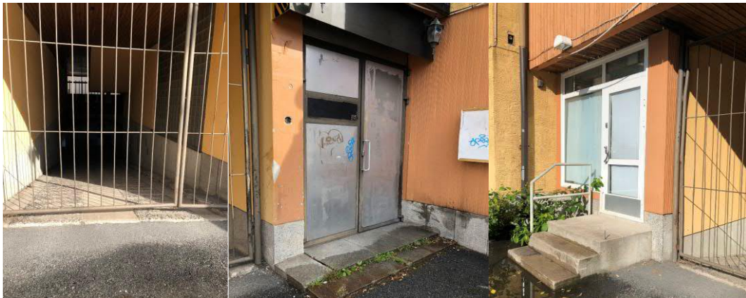
Kuva: 43 Julkisivua lounaaseen.
