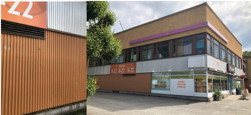
Kuva: 44 Julkisivua luoteeseen.
