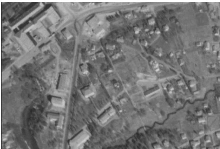
Kuva: 17 Ilmakuva vuodelta 1966. Souranderintien varteen on rakentunut ensimmäinen kerrostalo ja Nokian valtatie ja Souranderintien risteykseen liiketalo Sotkanvirta.
