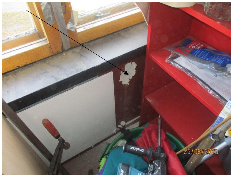
Kuva 10. RA3, ulkoseinän rakenneavaus, näyte nro 6.
