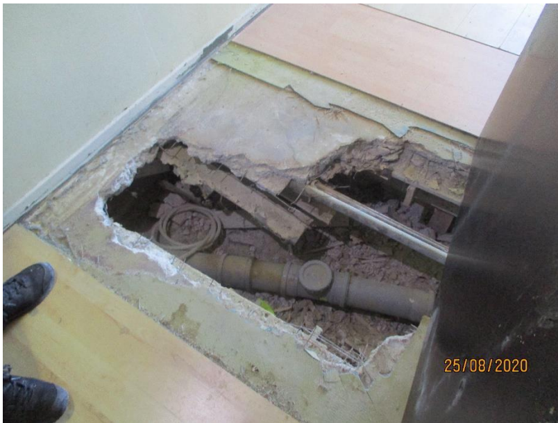
Kuva 11. RA4. Välipohjan pukkiholvi. Näytteet nrot 3 ja 4.
