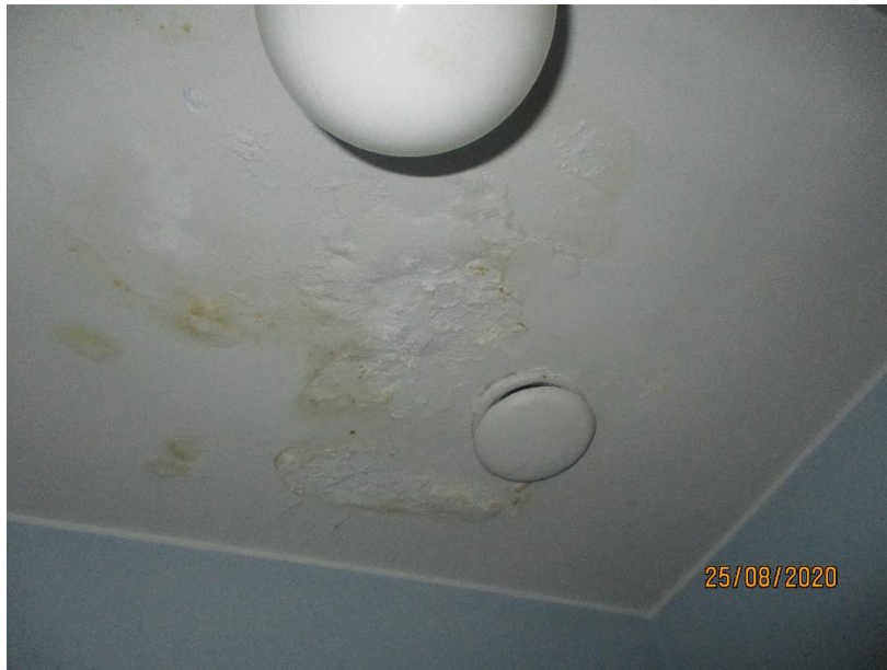
Kuva 7. Kattojen vaurioita.
