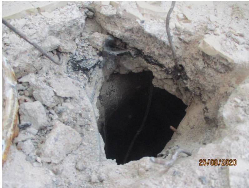
Kuva 12. RA5. Välipohjan pukkiholvi. Näytteet nrot 7 ja 9.
