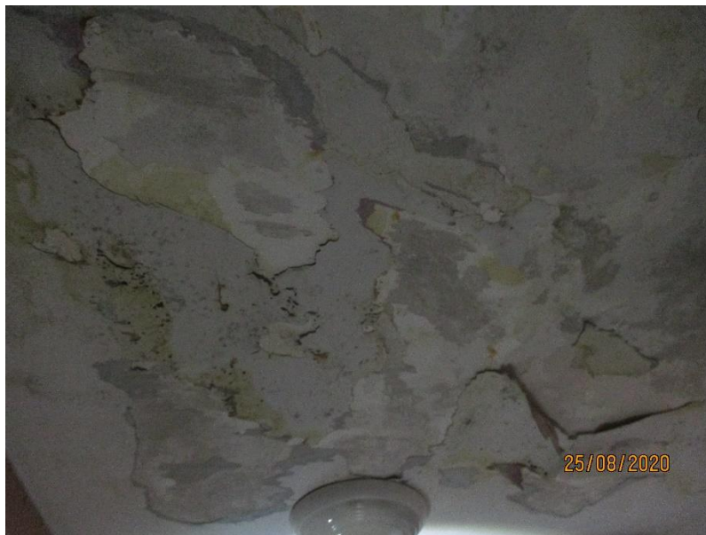
Kuva 6. Sisäkattojen vaurioita.
