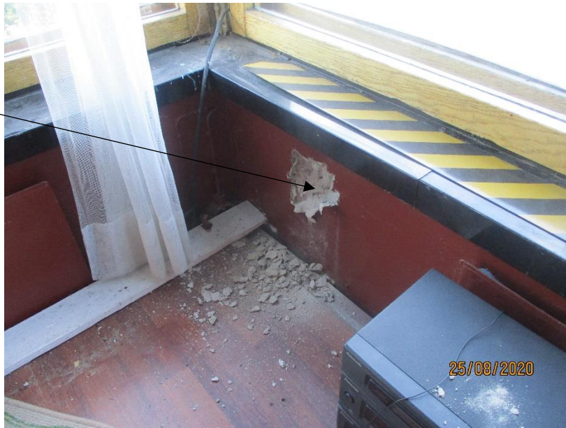
Kuva 9. RA2, ulkoseinän rakenneavaus, näyte nro 5.
