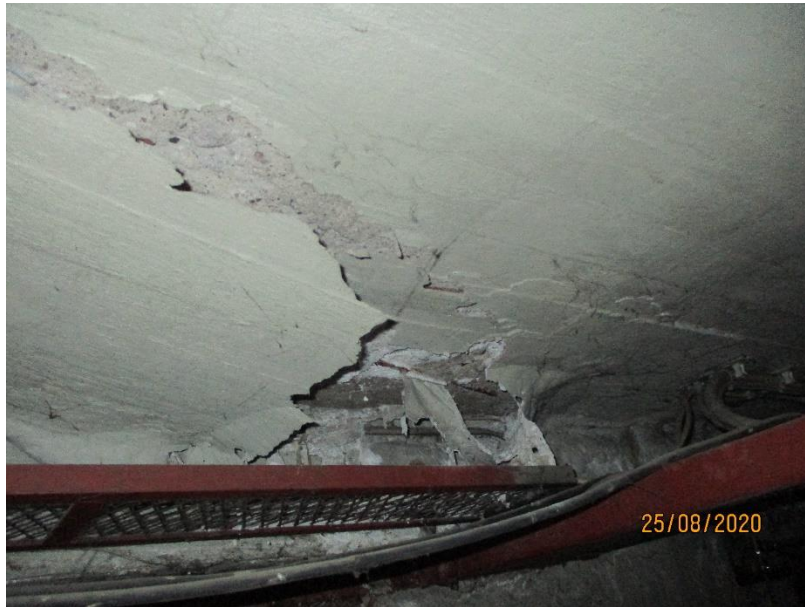
Kuva 14. Näyte 8. Sisäkaton tasoite.
