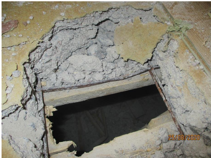
Kuva 13. RA6. Välipohjan pukkiholvi. Näytteet nrot 10 ja 11.
