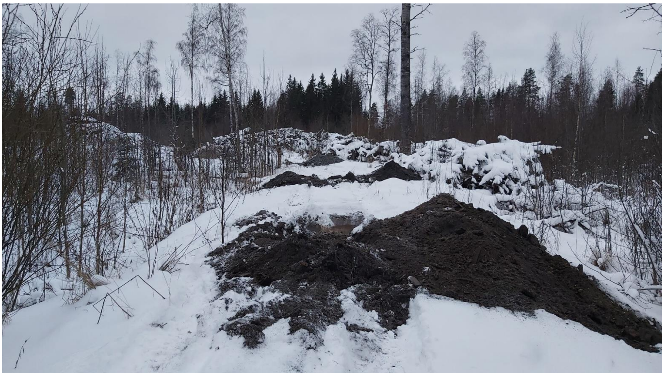
Kuva 4. Koekuoppia kaivettiin tiehen noin 10 metrin välein.
