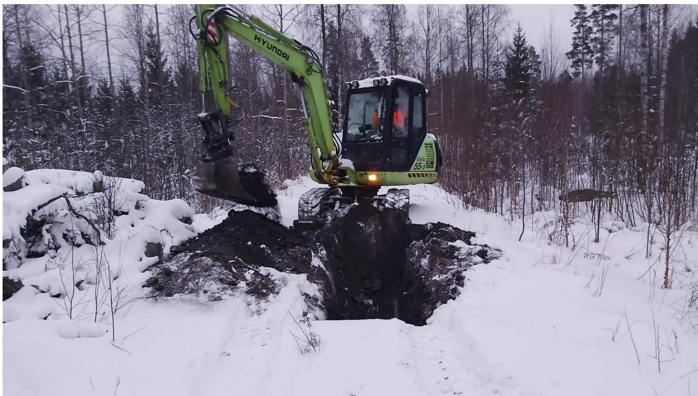
Kuva 1. Koekuopan kaivuutyötä tiepohjaan.
