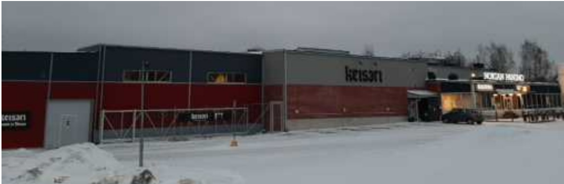
Kuva 3. Panimorakennus etelästä katsottuna
