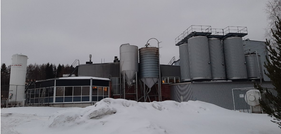
Kuva 5. Panimorakennus idästä katsottuna
