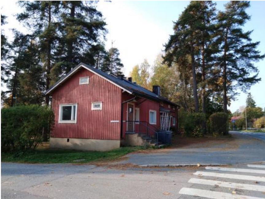
Kuva 3: Koskenmäen entinen kirjasto. (Kuva Nokian Koskenmäen yleisten korttelialueiden rakennusten inventointi ja kaupunkikuvallinen analyysi, Sweco Infra & Rail Oy 6.11.2020)
