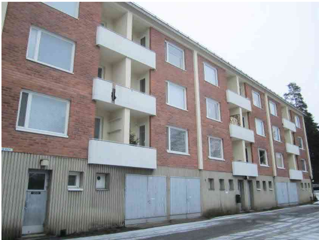
Rakennus B:n eteläjulkisivu
