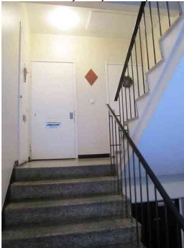
Porrashuone, jossa mosaiikkibetoniporaat ja metallikaiteet ovat alkuperäisiä
