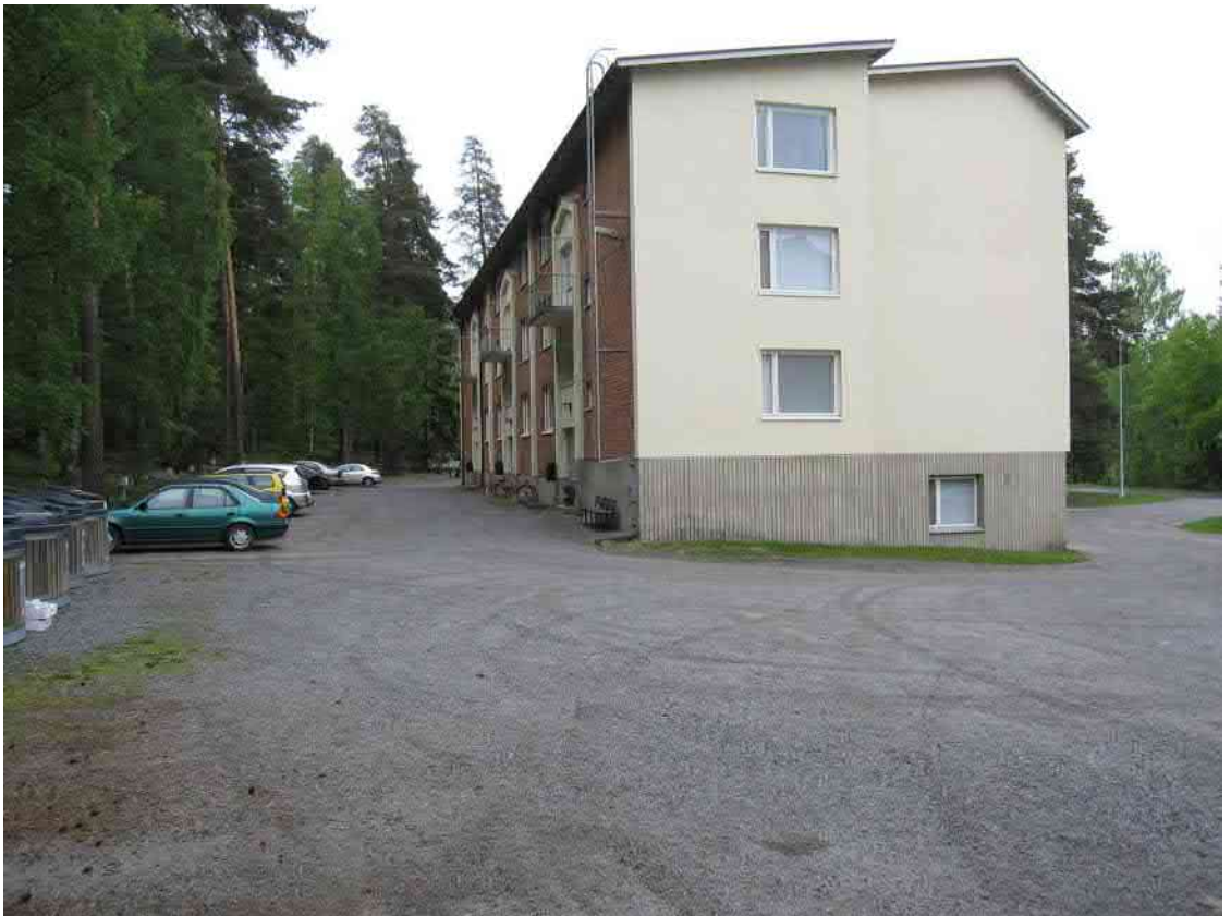
Rakennus A:n piha-alueita
