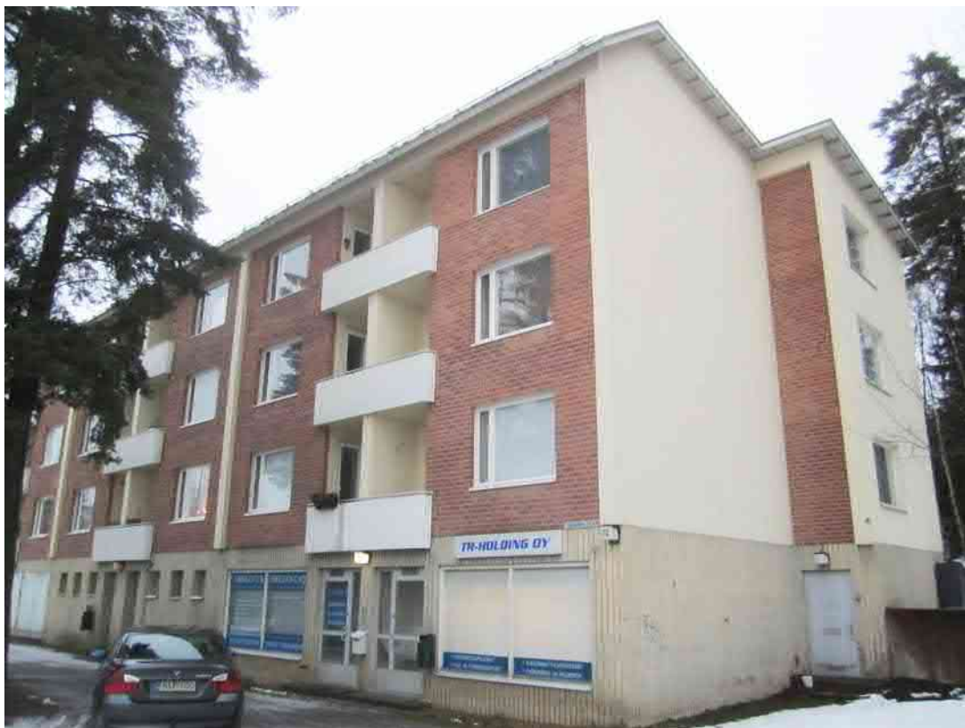
Rakennus A:n eteläjulkisivu, liiketila
