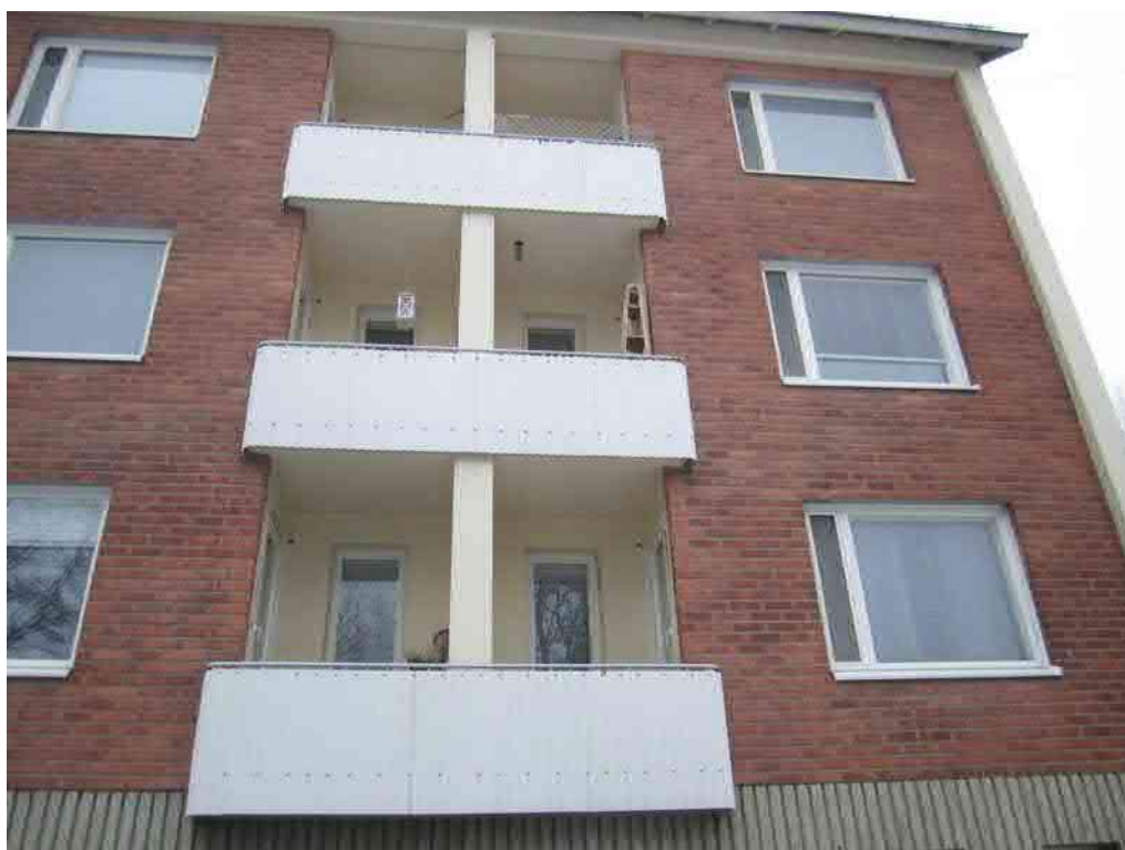
Rakennus B:n metallilevyllä päällystetyt parvekkeet ja uusitut ikkunat
