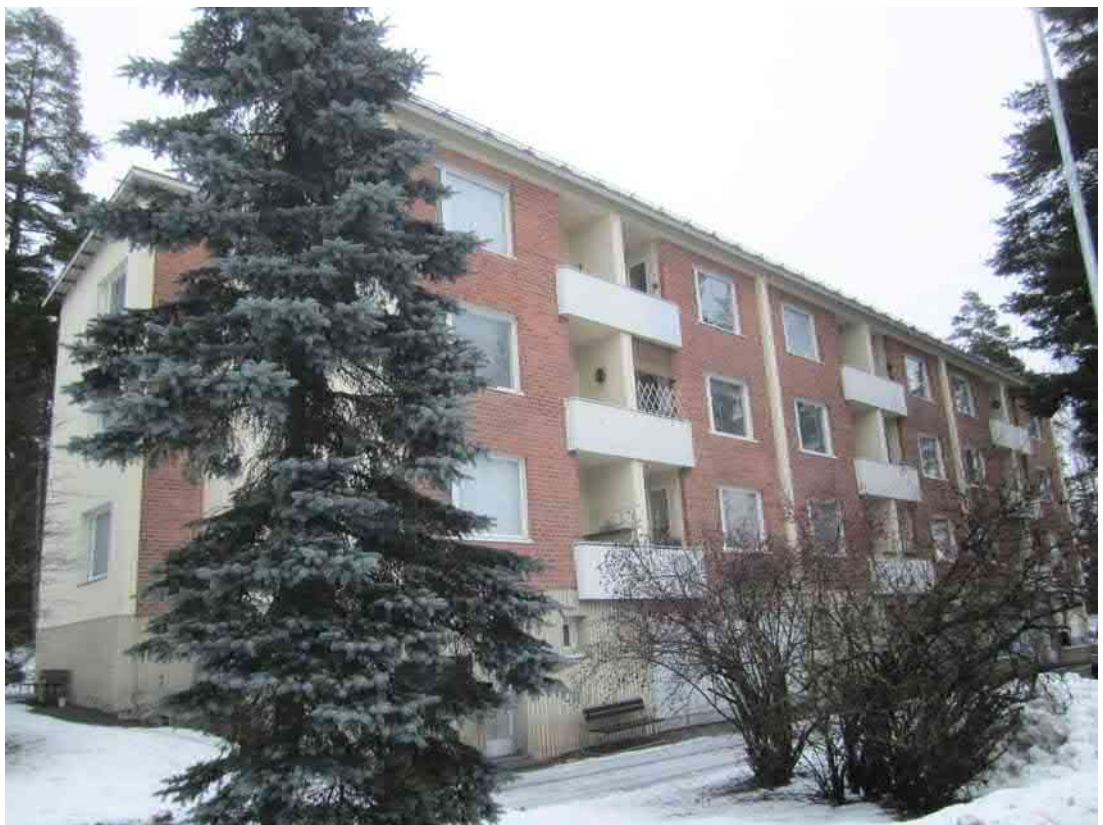
Rakennus A:n eteläjulkisivu
