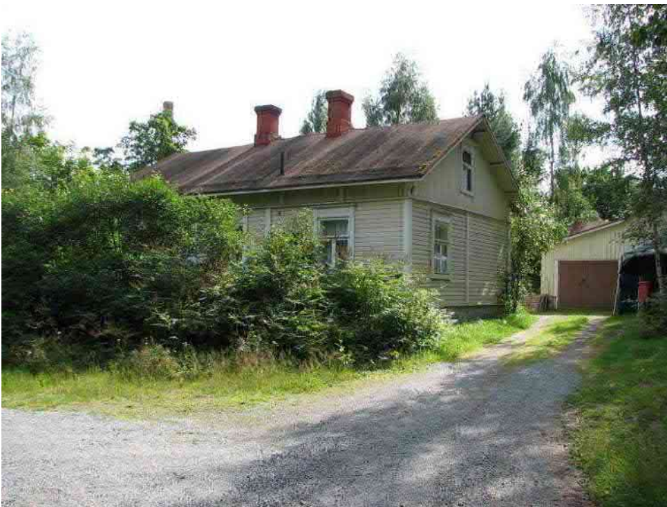
Kuva: Asuinrakennus ja talousrakennus.
