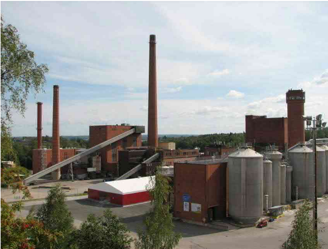
Kuva: Voimalaitoksen ja selluloosatehtaan rakennuksia
