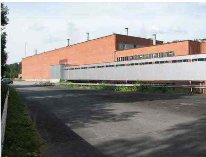
Kuva: Paperivaraston ja paperikone 9 konehallin yhdistävä, vuonna 1999 valmistunut putkitunneli vahvistaa tehtaan eteläisivun vahvasti horisontaalista julkisivua. Metallijulkisivun taustan muodostavat paperitehtaan vuosina 1961, 1965 ja 1971 valmistuneet tiilirakennukset, joissa näkyy nopea tuotantotilojen kasvutarve.
