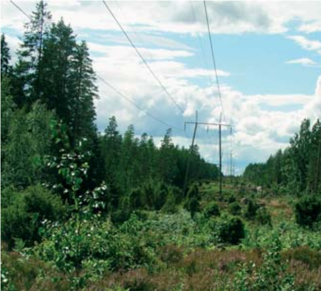
■ Kuva 5.8 Hankealueen eteläpuolella oleva voimalinja.
