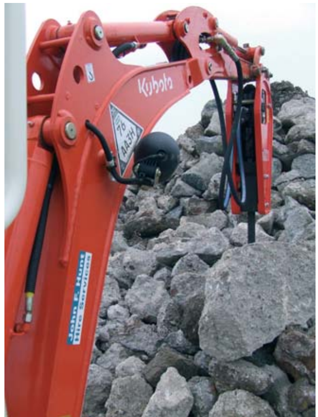
■ Kuva 3.5 Hydraulinen iskuvasara rikottamassa.
