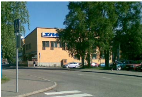
Maununkadun ja Nokianvaltatien kulmauksessa on 2-kerroksinen liiketalo vuodelta 1958 (Sotkanvirta), joka on osa maakunnallisesti arvokasta aluetta.
