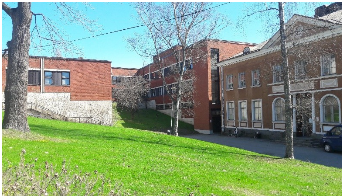
Liitos vanhaan sairaalaan on tehty terveystieteiden tutkimuskeskuksen rakentamisen 1. vaiheessa.
