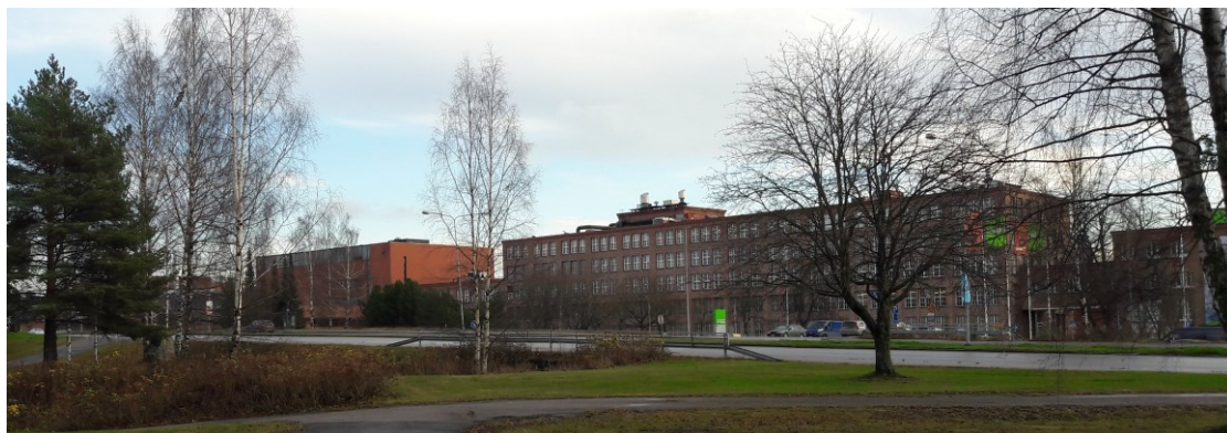
Kuva: Julkisivu kaakosta katsottuna
