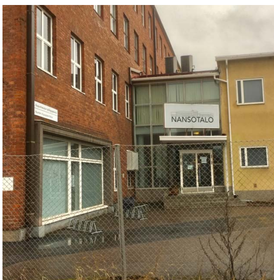
Uusi pääsisäänkäynti (rak. v. 1959), vasemmalla ikkunoin suljettu tehtaan vanha (rak. v. 1941) pääsisäänkäynti.
