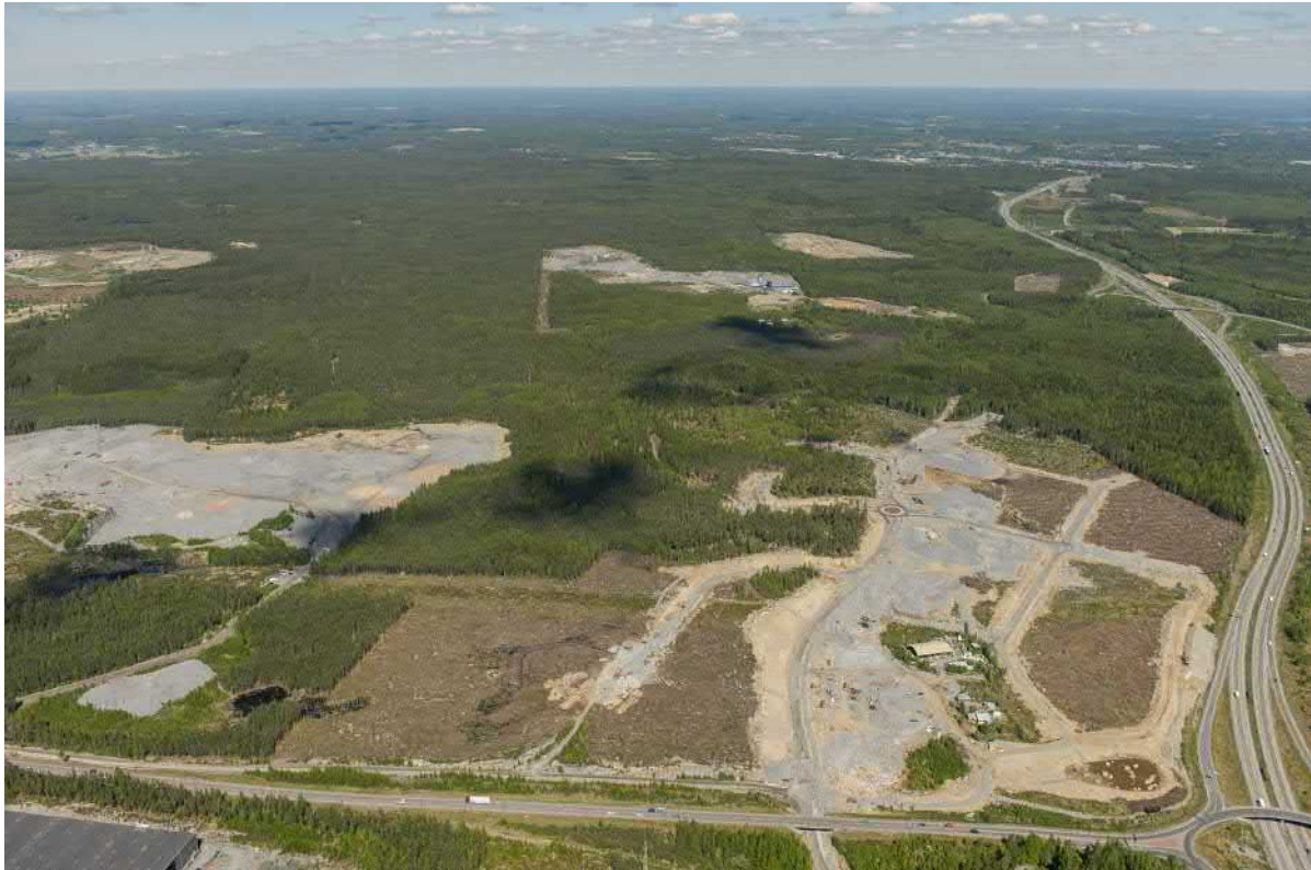
Etualalla rakentuva Juhansuon asemakaava-alue valtateiden 11 ja 3 risteyksessä. Taustalla Rudus Oy:n ja NCC Roads Oy:n maa-ainesten ottoalueet.
