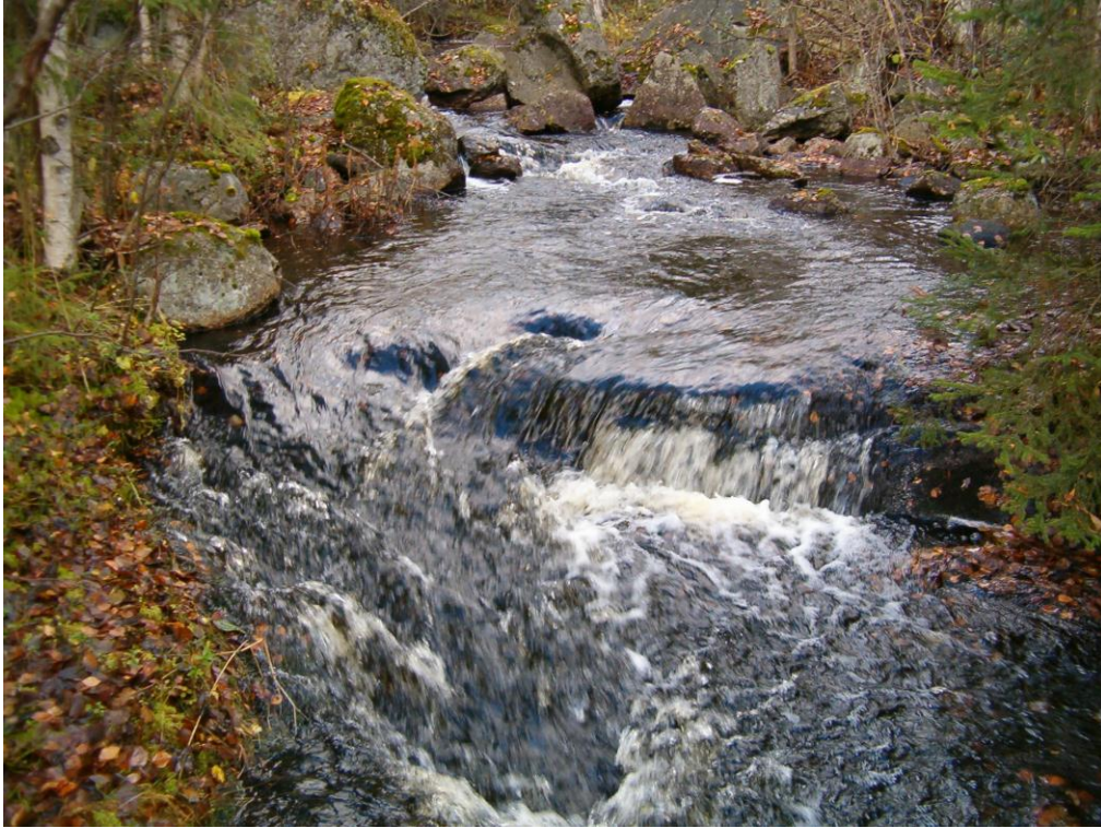
Kuva 24 Paaluväli 010-030. Koski on luonnontilaista eikä vaadi toimenpiteitä.
