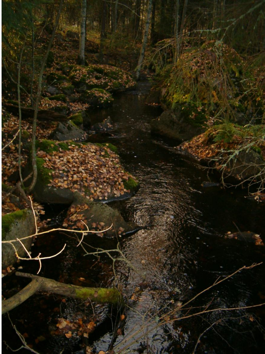
Kuva 29. Paaluvälin 020-080 perattua koskea. Uoman reunoilla olevat kivet on siirrettävä takaisin uomaan.
