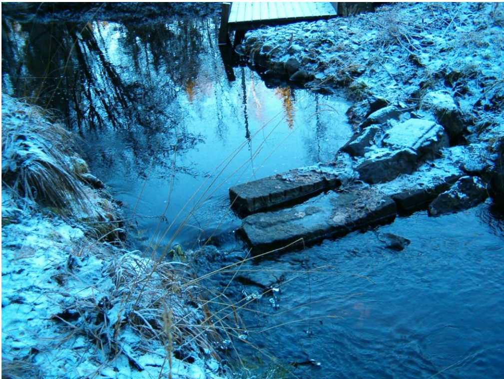
Kuva 13 Paalulla 110 sijatseva pato. Kalalle on jätetty kulkuväylä uoman vasempaan reunaan. Pato ei vaadi toimenpiteitä.
