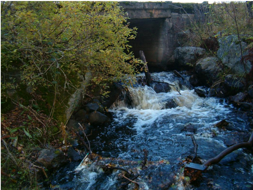
Kuva 2. Kohteen 1 paalulla 070 oleva kynnys. Kynnystä on muutettava loivemmaksi kalan kulun helpottamiseksi.
