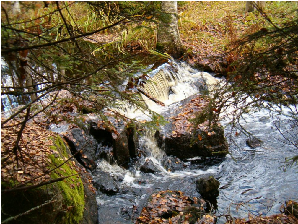
Kuva 9 Paalulla 070 sijatseva patorakennelma. Padon vasen reuna on rakennettu kivistä ja on mahdollisesti purettava kalan kulun varmistamiseksi.
