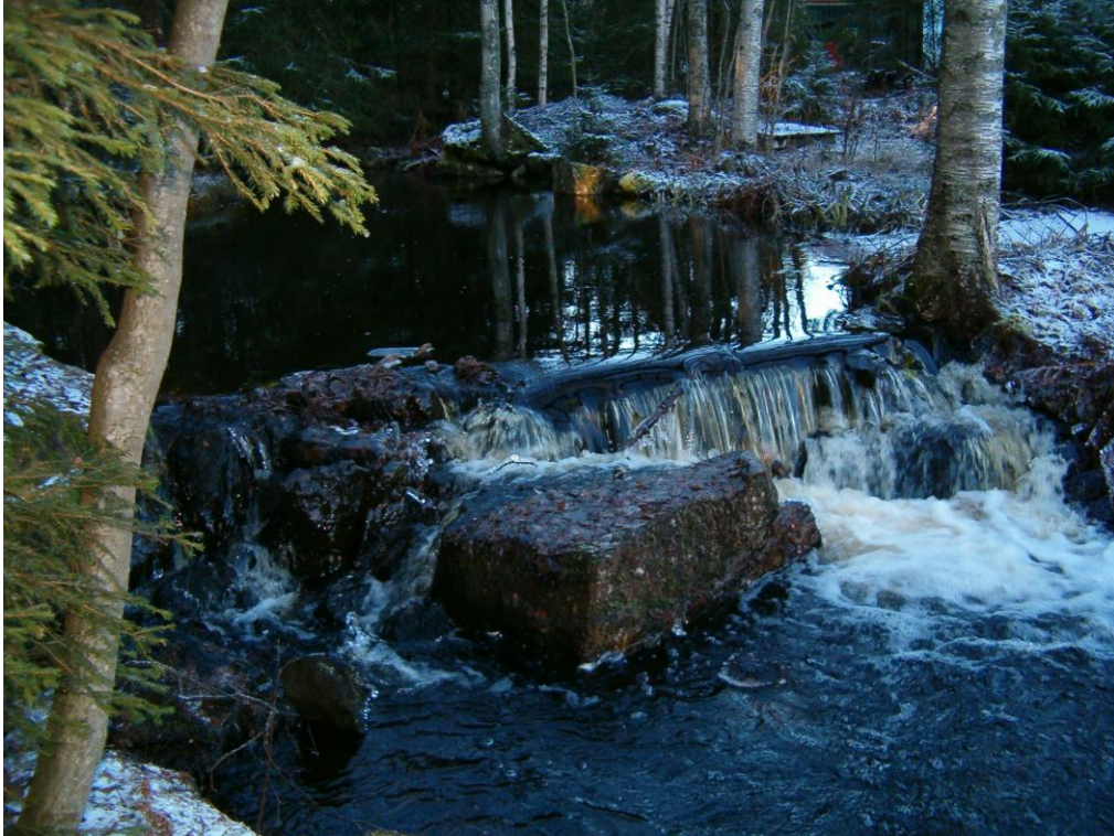
Kuva 10. Lisää kuvia paalun 070 patorakennelmasta.
