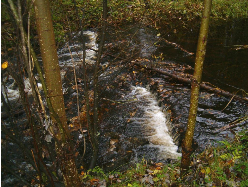
Kuva 3. Kohteen 1 paalulla 120 sijaitseva betonipato. Patoon tulee avata kulkuväylä joka mahdollistaa kalan kulun pienemmilläkin virtaamilla.
