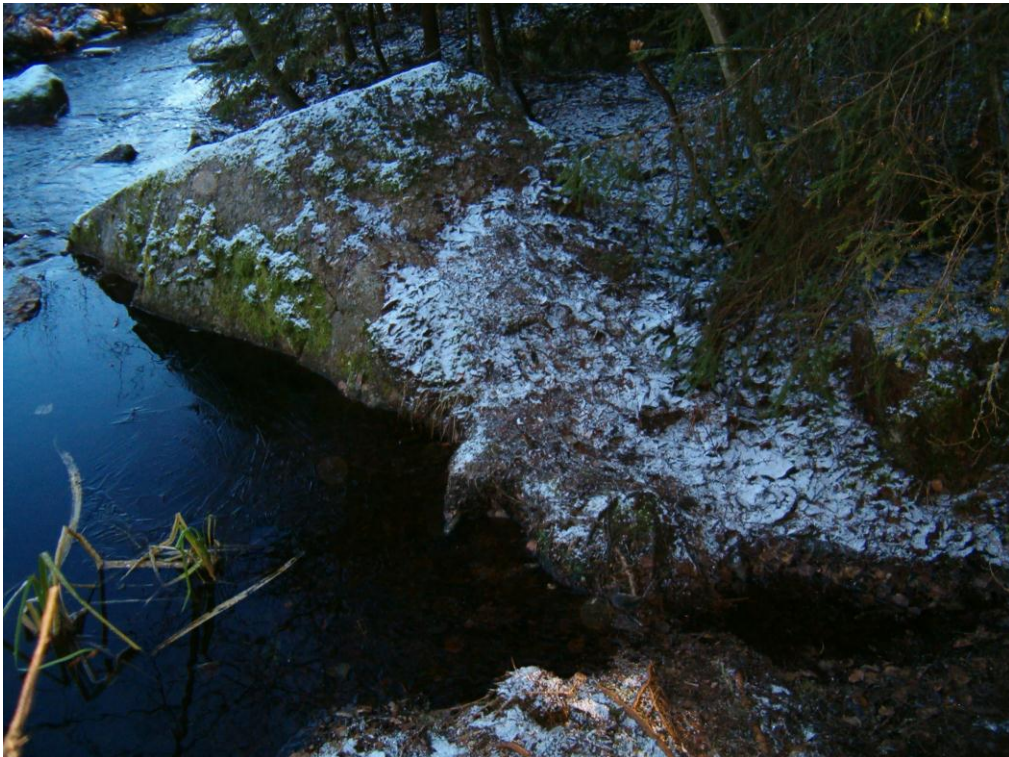
Kuva 11. Kuva paalulta 075. Mikäli patoa ei voida purkaa tai kynnstä loiventaa, voidaan osa vedestä johtaa kuvassa näkyvän kiven ympäri.
