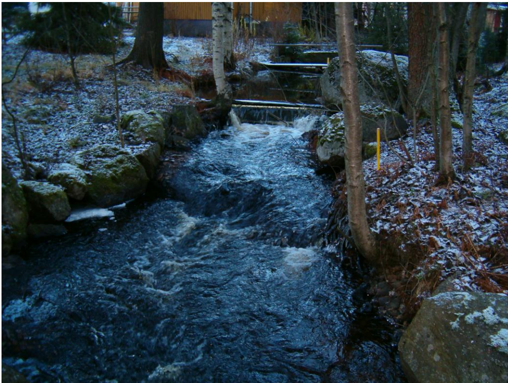
Kuva 3. Kohteen 3 paalulla 175 oleva metallinen pato. Pato estää kalan nousun ylävirtaan.
