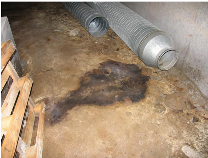
Kuva 3. Öljyläikkä maavaraisen kellarin lattialla.
