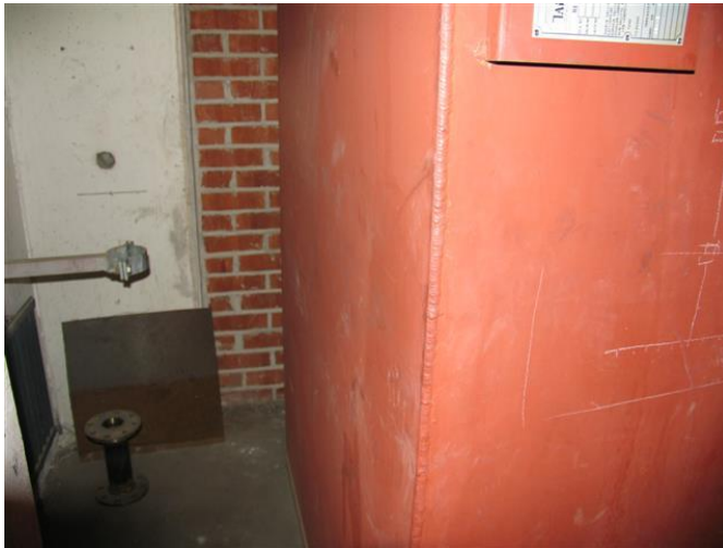
Kuva 2. 18 m 3 kevytöljysäiliö kellarissa.
