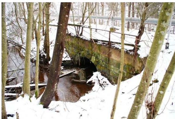
Laajanojan silta nk. Lemmensilta.
