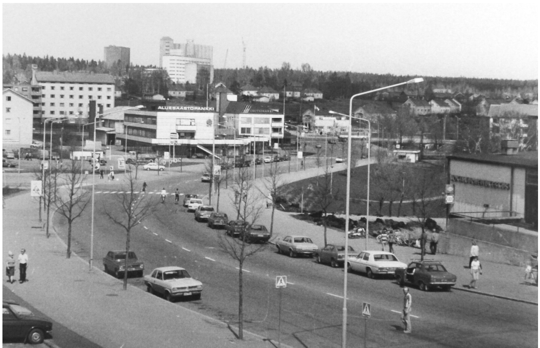
Kuvassa Härkitien ympäristöä n. 1970-luvun lopulla. Keskellä Aluesäästöpankki ja Pelkosen talo, johon on jo muuttanut Osuuspankki. Osuuspankkitalo on rakennusselostuksen mukaan perustettu kokonaan puupaalutuksen varaan, kantava runko on teräsbetonista, lisäksi kennotiilimuuraus, välipohjina teräsbetonilaatat. /Nokian kaupungin valokuvakokoelma
