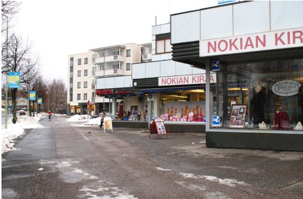
Entinen säästöpankkitalo on säilynyt yksityiskohtia myöden hyvin rakennusaikaisessa asussaan. Talon Härkitien puoleinen matala ja porrastettu osa tekee katutilasta omintakeisen.
