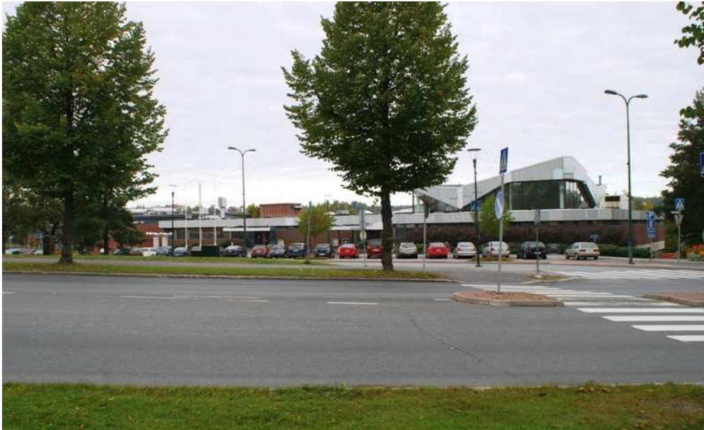
Uimahalli kuvattuna Välimäenkadulta. Rakennus sijaitsee liikekadun itäpäässä.
