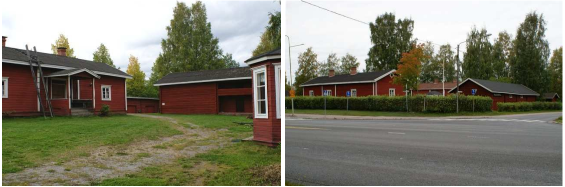
Hinttalan Kotiseutumuseo. Nokian valtatie ja Vihnuskadun risteysalue on laajentunut ja työntynyt lähelle Hinttalan rakennuksia.
