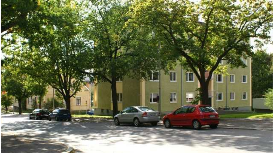
Päiväkotirakennus ja Souranderintie 18 kerrostalo.
