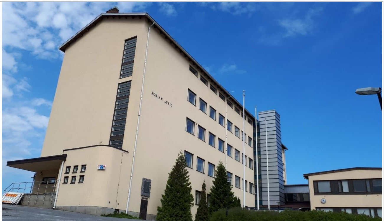
Nokian lukion päätydetaljit ja korkea ikkuna käytävän päässä.
