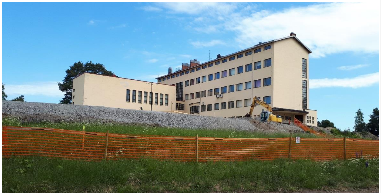
Näkymä lounaasta Nokian lukion vanhimpaan osaan ja käynnissä olevalle työmaalle.
