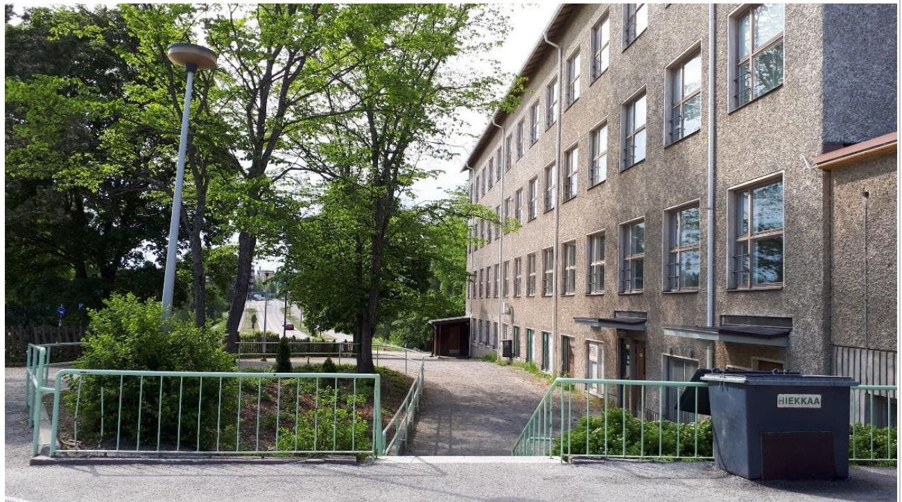
Kankaantaan koulun pihan etelään laskeva osa ja luokkien ikkunoita julkisivussa.
