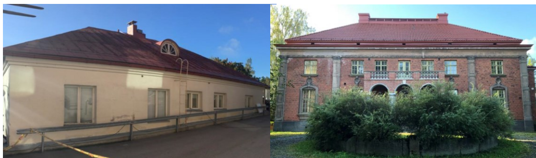
Kuvat: Sauna ja Hakkalinna
