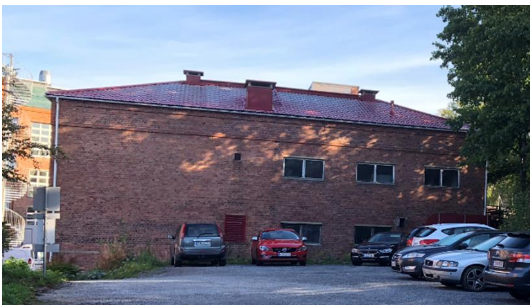
Kuva: 36 Autotallin julkisivu etelään.
