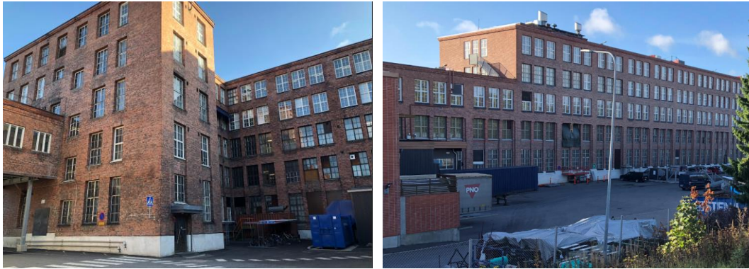
Kuva: 8 Rengastehtaan vanhimmat osat ovat 1940-luvulta ja niitä on korotettu kahdella kerroksella 1950-luvulla.
