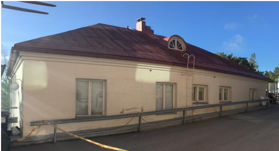
Kuva: 32 Sauna kuvattuna pohjoisesta tehtaan suunnasta.
