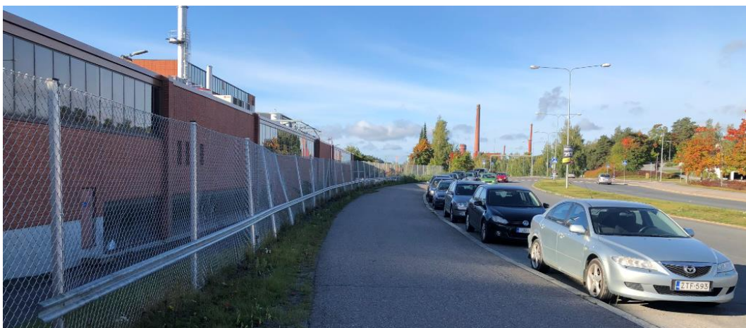
Kuva: 5 Kumitehtaan noin 500 metriä pitkä julkisivu Pirkkalaistien varrella rajaa Nokian keskustaa etelän suunnasta.
