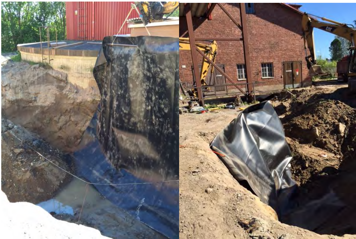
Kuva 9. Kalvon asentaminen pilaantuneen maa-aineksen päälle
