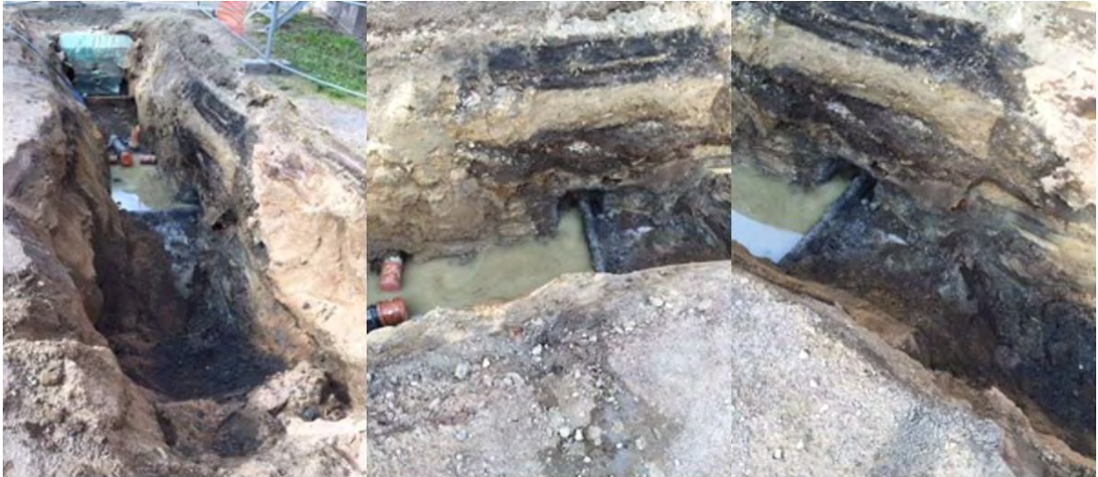
Kuva 2. Pilaantuneisuuden havaitseminen työn alussa 27.7.2015
