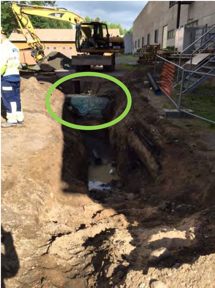
Kuva 4. Puhdistettu kohta ennen täyttööä 28.7.2015
