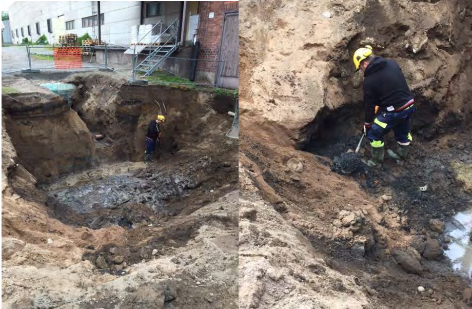
Kuva 5. Pilaantuneisuutta kaivannon edetessä 31.7.2015
