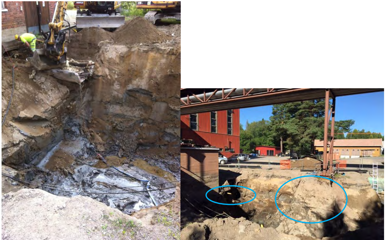
Kuva 7. Vas. kuvassa puhdasta rajapintaa 12.8.15 ja oik. kuvassa alueet, joille jäi pilaantunutta maata 14.8.15
