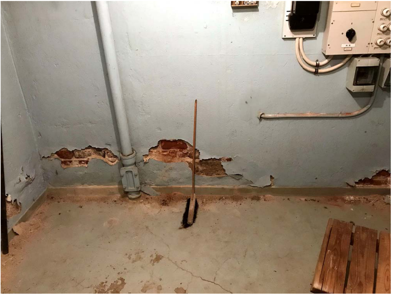
Pohjakerroksen / kellarin kosteusvaurioita
