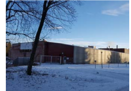
Rakennuksen luoteispääty, etualalla pres-suhalli
