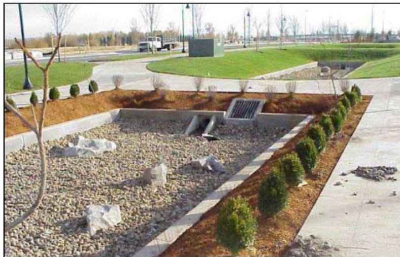
Kuva 10. Avoin imeytyskaivanto luonnossa.
