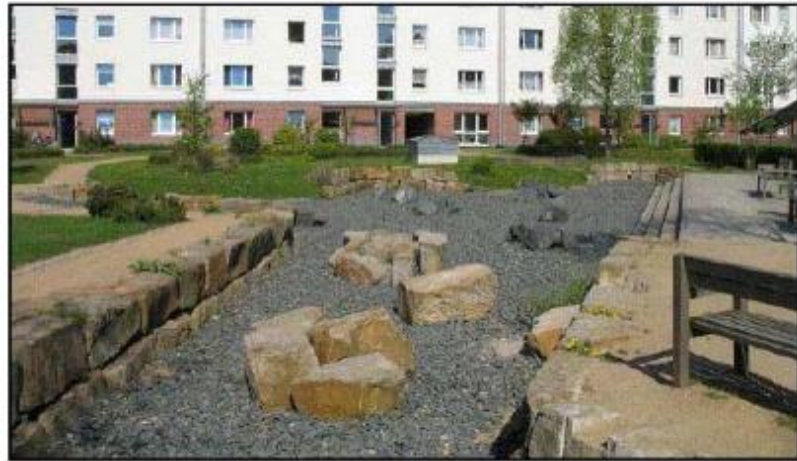
Kuva 15. Kuiva, kivetetty viivytuspainanne.
