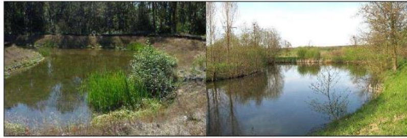
Kuva 14. Erilaisia hulevesilammikko rakenteita.
