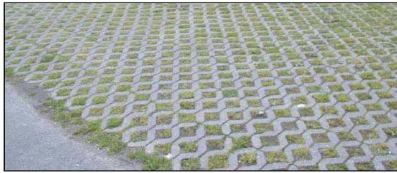
Kuva 8. Läpäisevä päällyste, betoninen reikälaatta nurmetettuna.
