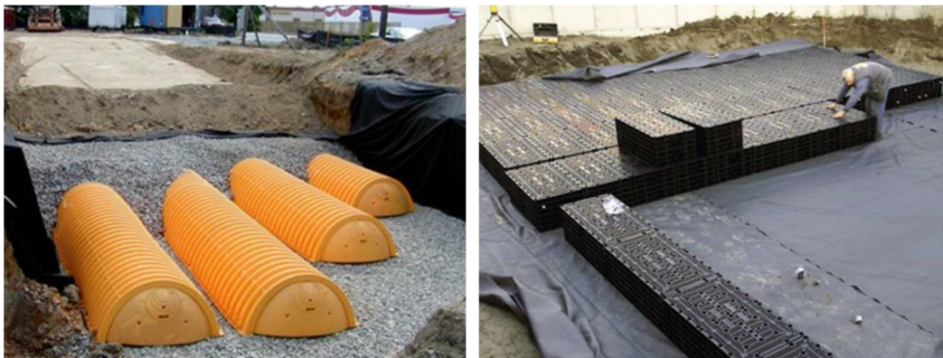
Kuva 5.4. Hulevesitunneli (Kaitos) ja Hulevesikasetti (Uponor Oy)
