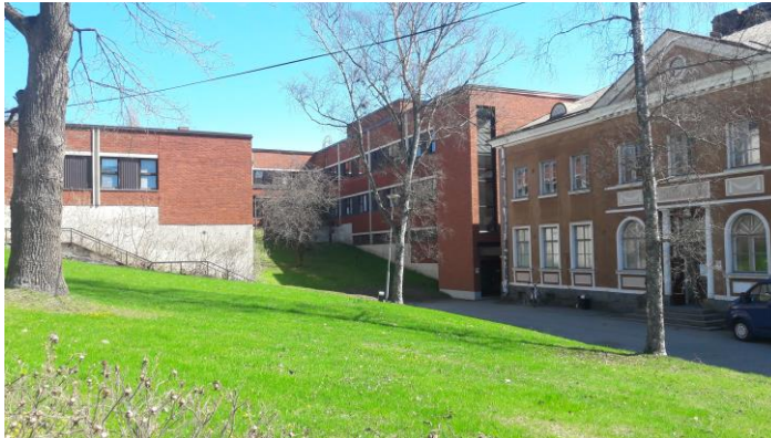
Liitos vanhaan sairaalaan on tehty terveystieteiden keskuksen rakentamisen 1. vaiheessa.
